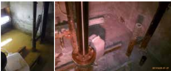
Imágenes del foso de elevador antes y después de la aplicación del impermeabilizante por cristalización
