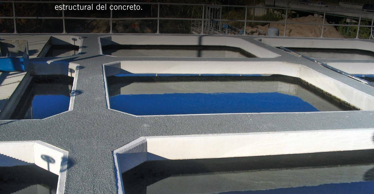
Los productos Xypex asumen un rol clave en la impermeabilización y protección del concreto contra presiones hidrostáticas, agrietamiento, fugas en juntas, ataque químico y deterioro de las superficies – problemas típicos que se encuentran en numerosas estructuras que forman parte del proceso de tratamiento de agua potable.
