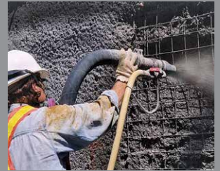
Concreto lanzado
