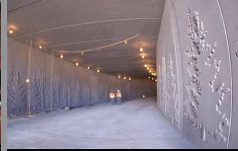
Túnel Bremerton, EUA
