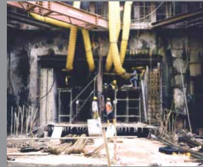
Concreto vertido en sitio
