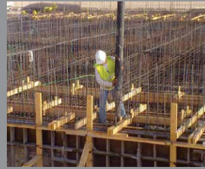
Concreto vertido en sitio
