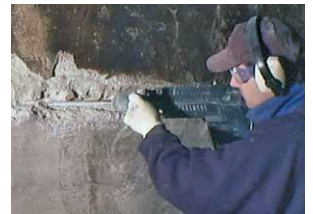
Rehabilitación Patch'n Plug & Megamix
