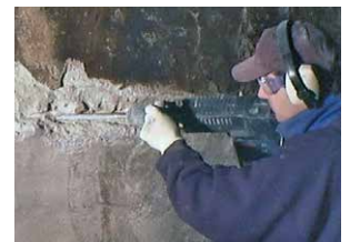
Rehabilitación Patch'n Plug & Megamix
