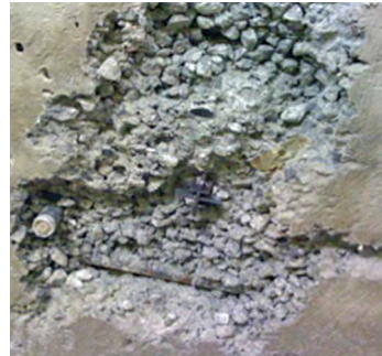
Defectos constructivos (segregación, nidos / hormigueros y agujeros de sujeción sin reparar)
