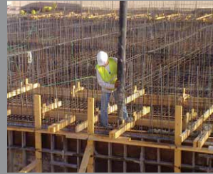
Concreto vertido en sitio
