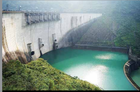
Reservorio Taipei Feitsui, Taiwán
