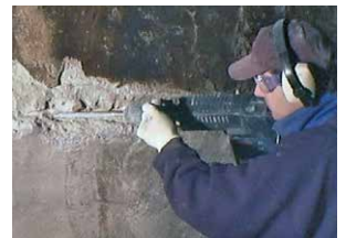
Rehabilitación Patch'n Plug & Megamix
