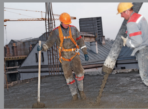
Hormigón colado in situ
