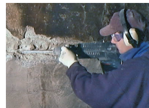
Rehabilitación Patch'n Plug y Megamix
