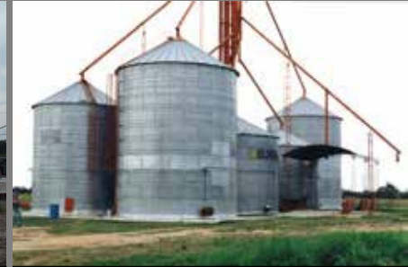
Gabonátároló Siló, Calafate S.A. Argentína
