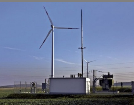
Szélenergia transzformátor alap, Sopronkövesd
