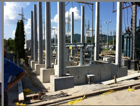
Transzformátor állomás, oszlop alapok, Károlyfalva
