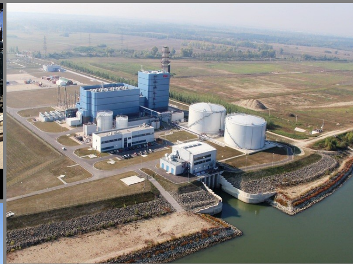
E.On Erőmű, olajlefejtő és vízterelő műtárgyak, Gönyű
