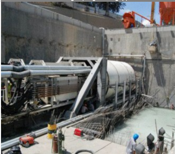
Fúrt alagút (alagútfúró gép)
