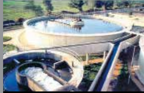
Shebin El Koum Sewage Stn., Egypt
