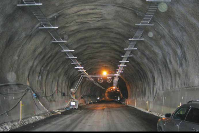
Vuoli Tunnel, Finland
