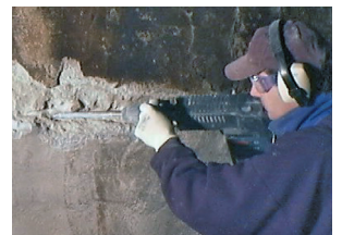
Sanacija Patch'n Plug i Megamix
