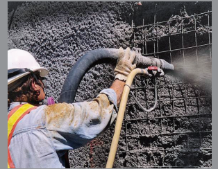
Tokom nanošenja betona prskanjem
