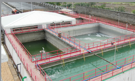
Postrojenja za pročišćavanje i odvodnju otpadnih voda Fiat, India Automobiles, Indija
