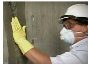
Zatvaranje pukotina Patch'n Plug
