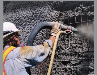
Tokom nanošenja betona prskanjem
