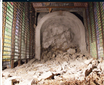
Bušenje i eksplozivna tehnika
