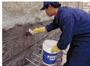
Premazivanje Concentrat i Modified
