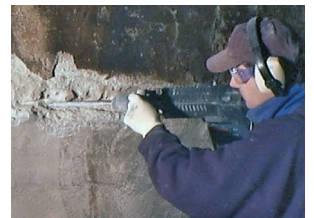
Sanacija Patch'n Plug i Megamix
