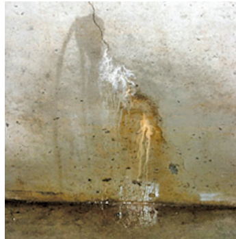
Curenje vode između betonskih spojeva
