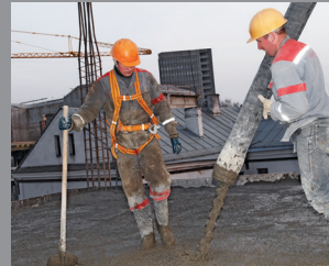
U toku ugradnje
