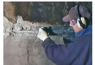
Sanacija Patch'n Plug i Megamix
