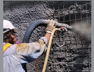
Tokom nanošenja betona prskanjem
