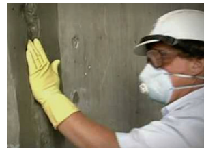
Zatvaranje pukotina Patch'n Plug
