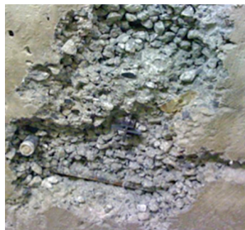
Oštećenja na konstrukciji (segregacija betona, pukotine, gnijezda i netretirane rupe od distancera)
