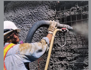
Tokom nanošenja betona prskanjem
