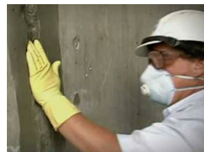
Zatvaranje pukotina Patch'n Plug
