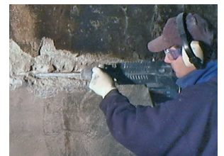
Sanacija Patch'n Plug i Megamix
