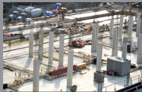
Postrojenje za pročišćavanje vode Croton UV, SAD
