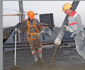
U toku ugradnje
