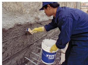
Premazivanje Concentrat i Modified
