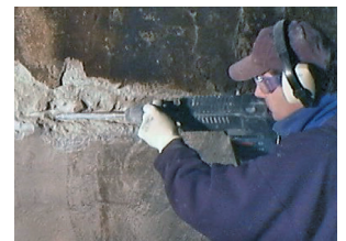
Sanacija Patch'n Plug i Megamix
