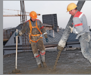
U toku ugradnje
