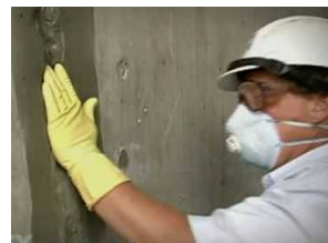
Zatvaranje pukotina Patch'n Plug
