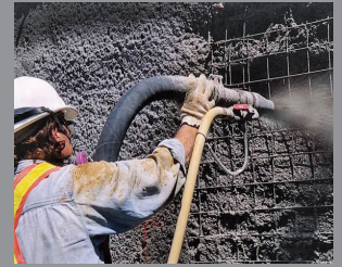
Tokom nanošenja betona prskanjem
