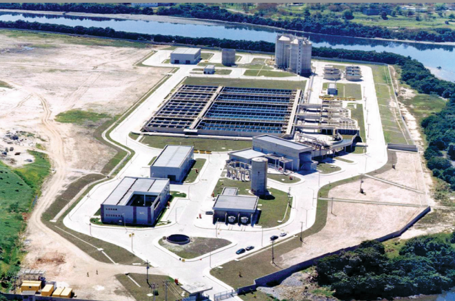
Postrojenje za preradu otpadnih voda Allegria, Brazil
