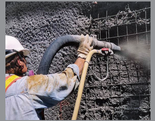
Tokom nanošenja betona prskanjem
