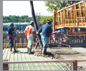
U toku ugradnje
