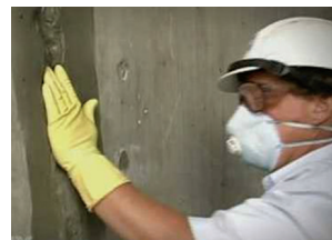
Zatvaranje pukotina Patch'n Plug
