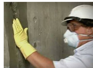
Zatvaranje pukotina Patch'n Plug
