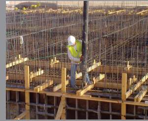
U toku ugradnje
