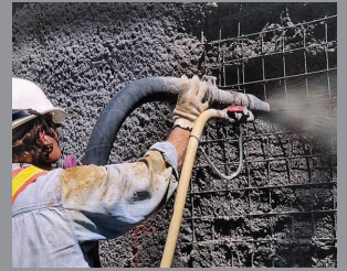
Tokom nanošenja betona prskanjem
