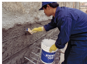
Premazivanje Concentrat i Modified
