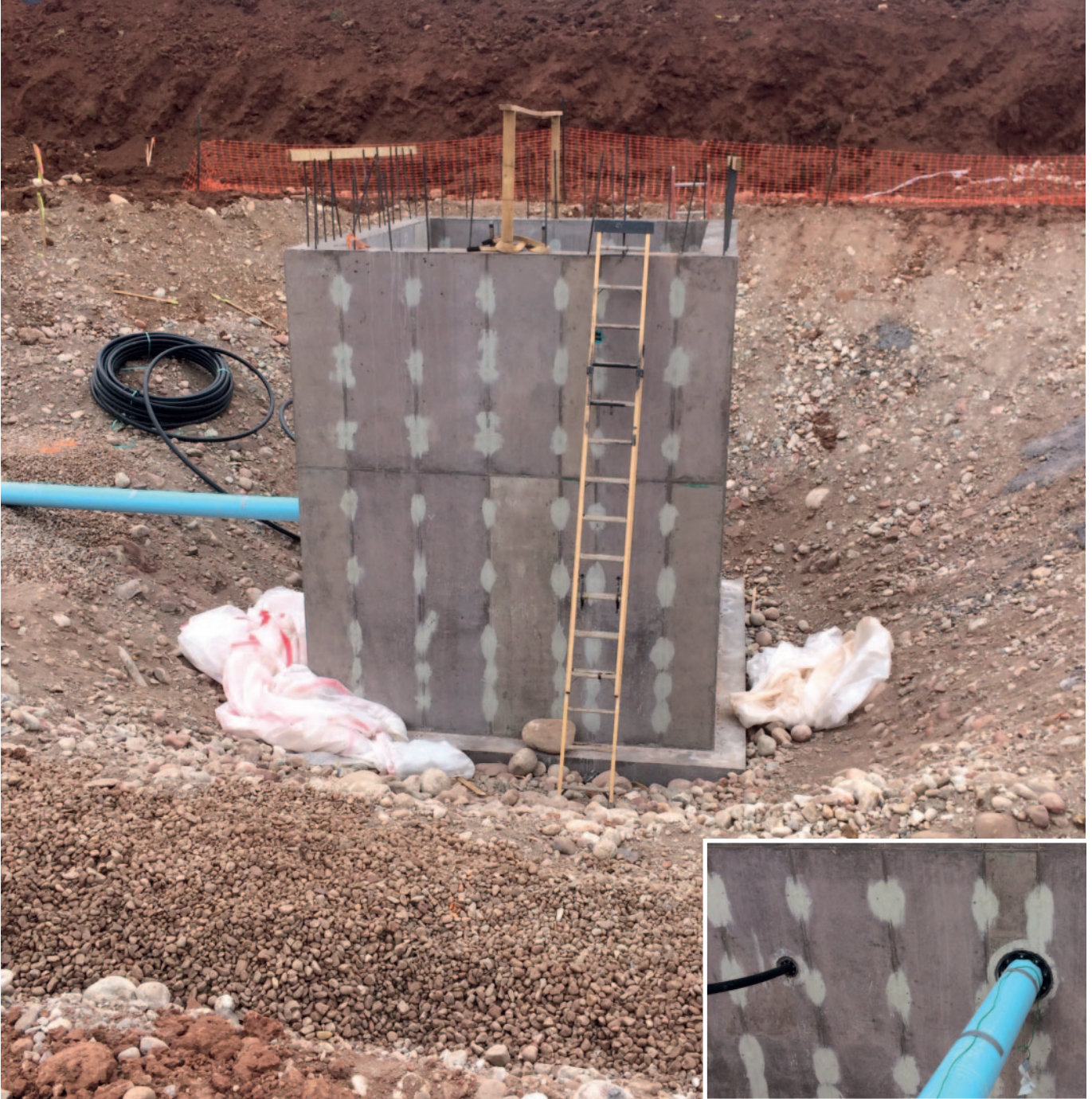
Şek. 4: Yerde dökme betondan yeni nakil istasyonu, ABD eyaleti Colorado'nun Basalt şehrindeki hususi Fork Club'ın genişletilmesi için kanalizasyonun bir parçasıdır. Yeni nakil istasyonu için hazır betona Xypex Bio-San C500, kristalize bir yalıtım ve antimikrobiyal bir katkı maddesi eklendi. Sağda nakil istasyonuna 8 inç besleme hattı (bakınız küçük fotoğraf) ve solda çıkan 2 inç gider hattı görülüyor.
