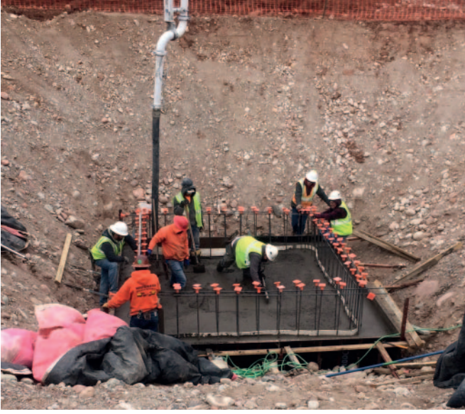
Şek. 5: Yeni nakil istasyonu için yaklaşık 45 cm kalınlıkta bir zemin plakası dökülüyor.
