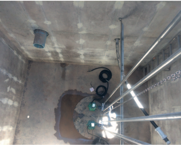
Res. 7: Yerinde dökme betondan yeni nakil istasyonunun üstten görünümü, ABD eyaleti Colorado'nun Basalt şehrindeki hususi Fork Club'ın genişletilmesi için kanalizasyonun bir kilit parçası.
