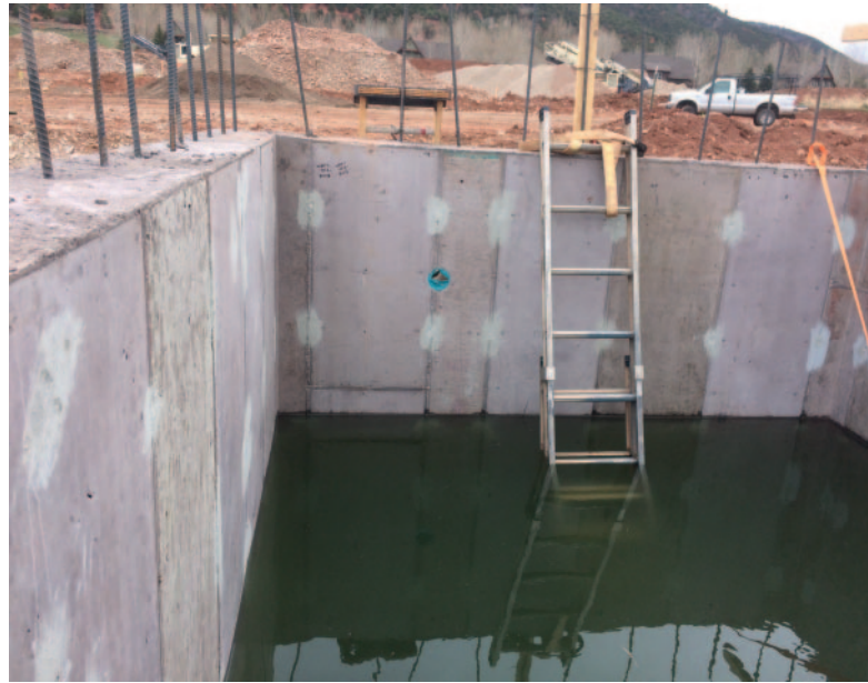
Res. 8: Hidrostatik test ilk defasında başarılı oldu.
