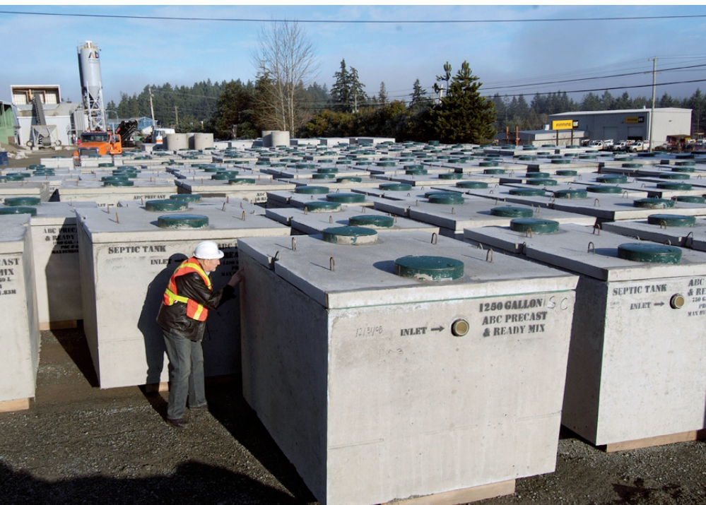
В настоящее время значительная часть сточных вод Северной Америки проходит очистку в септических хранилищах
