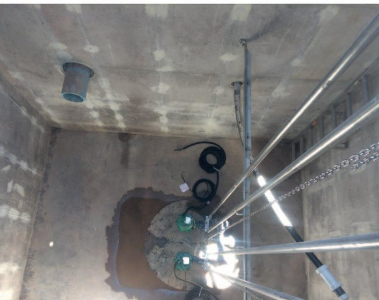
Fig. 7: Vista dall'alto della nuova stazione di convogliamento, un elemento chiave dell'infrastruttura fognaria dell'ampliamento dell'esclusivo Fork Club di Basalt nello stato USA Colorado.
