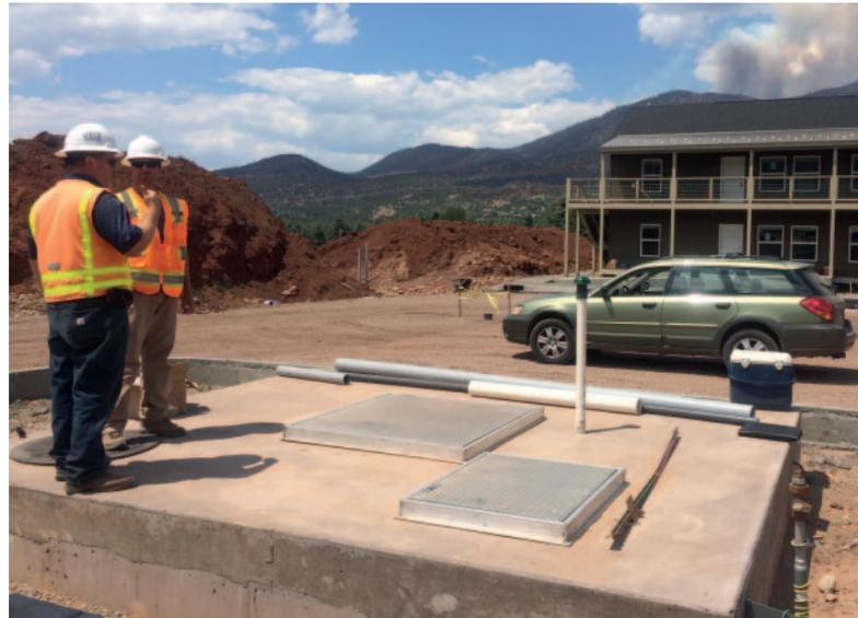
Fig. 6: Una copertura di circa 25 cm di spessore con portelli di ingresso viene gettata in calcestruzzo in opera.
