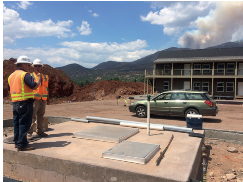
Abb. 6: Eine ca. 25 cm dicke Abdeckung mit Einstiegsluken wurde in Ortbeton gegossen.
