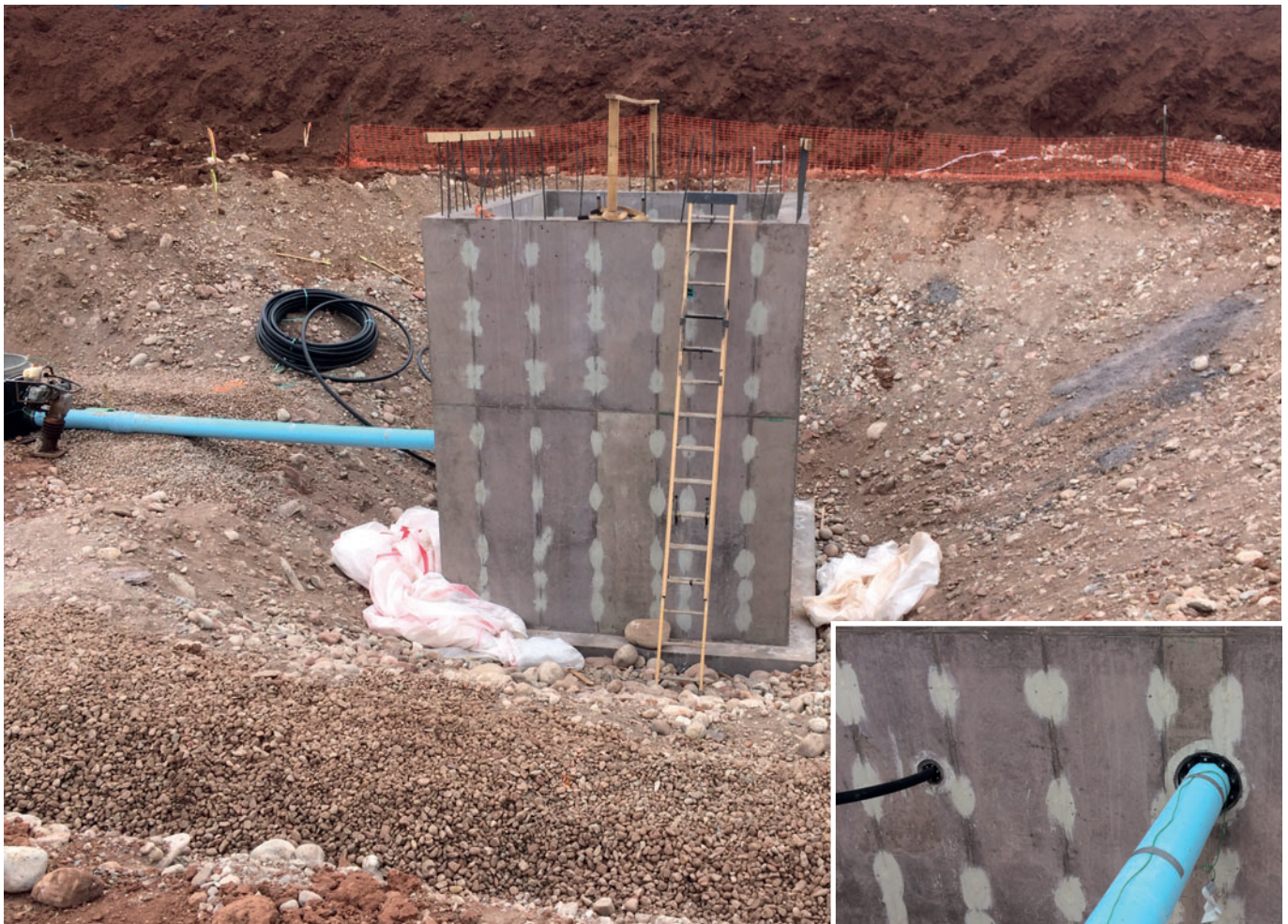
Abb. 4: Die neue Förderstation in Ortbeton ist Teil der Kanalisation für die Erweiterung des exklusiven Fork Club in Basalt im US-Staat Colorado. Dem Transportbeton für die neue Förderstation wurde Xypex Bio-San C500, eine kristalline Abdichtung und antimikrobielles Zusatzmittel, beigegeben. Man sieht rechts eine 8-Zoll-Zuleitung (siehe kleines Foto) zur Förderstation und links eine ausgehende 2-Zoll-Abflussleitung.
