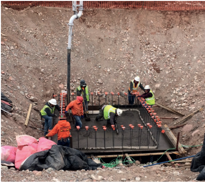
Abb. 5: Für die neue Förderstation wird eine ca. 45 cm dicke Bodenplatte gegossen.
