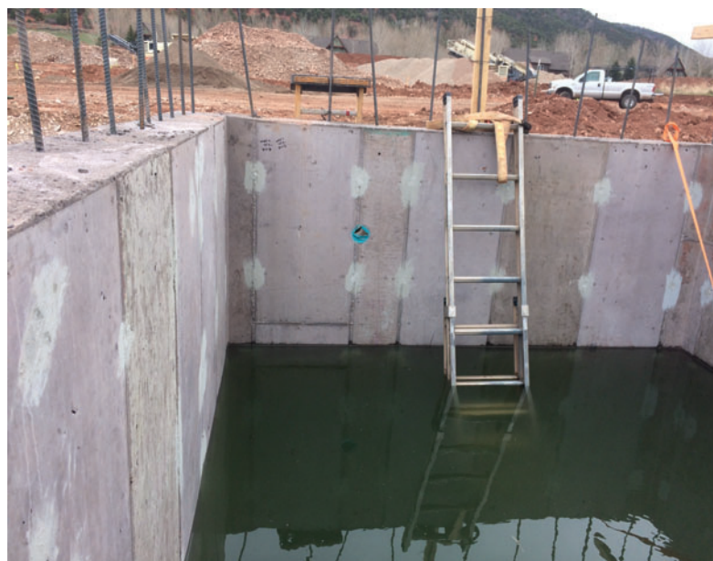
Abb. 8: Der hydrostatische Test war beim ersten Mal erfolgreich.
